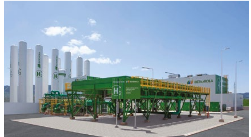
Centrale Iberdrola di pompaggio e stoccaggio di idrogeno verde a Puertollano, Ciudad Real (Spagna) 124
